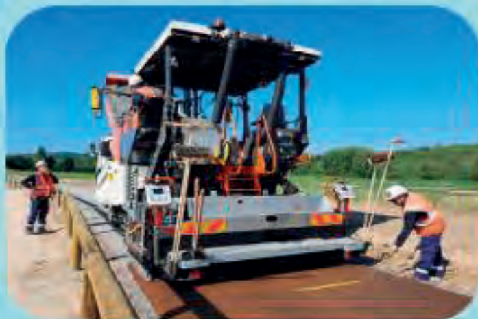
COURCELLES SUR SEINE – voie verte
